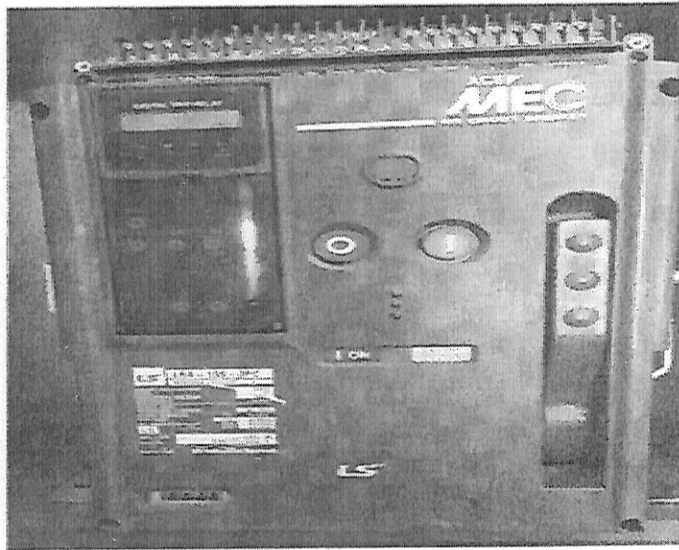
Fotoğraf 2. LBA-13S-3PC Motorlu Transfer Şalteri Görseli
