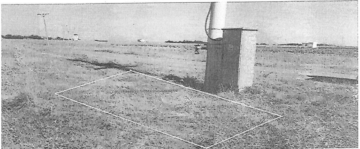
Fotoğraf 4. Muratlı İlçesi Aşağısevindikli 20 Nolu Su Kuyusuna Jeneratörün Konulacağı Alan
