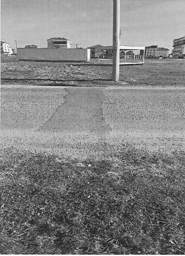
BRANŞMAN ALINACAK DİREK VE YAPILACAK YOL GEÇİŞİ
